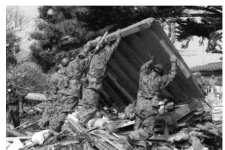
宮城県石巻東地区で壊れた家屋を人力により搜索活動する隊員(6連隊)
