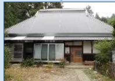
地域活性化のため、空き家を地域交流施設に活用
