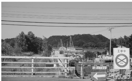
駒生川河川改修事業
