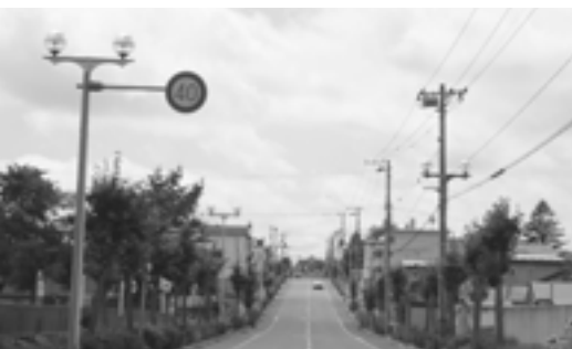
▲省エネ改修される街路灯（公園通）▲
