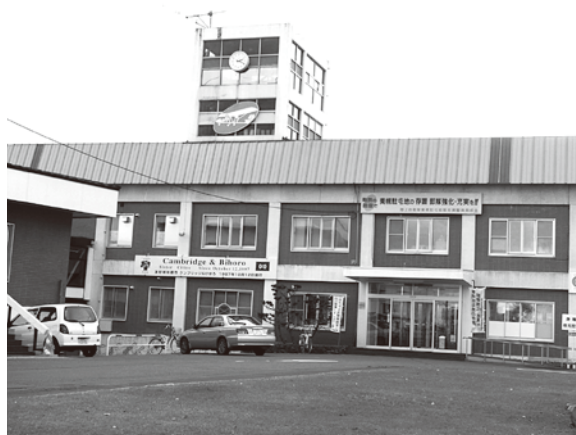
～ 建設から57年経過した役場庁舎 ～
