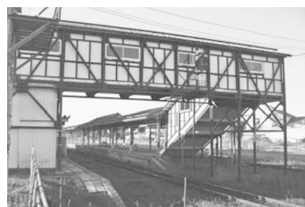
美幌駅跨線橋
