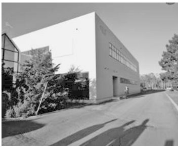
東京電波美幌工場
