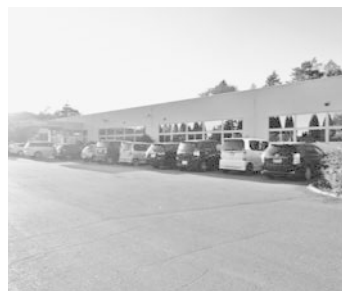
東京電波美幌工場
