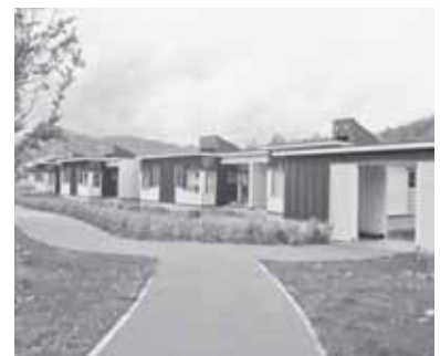
下川町一の橋地区「集住化住宅」
