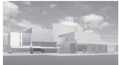
町民会館（平成30年完成予定）
