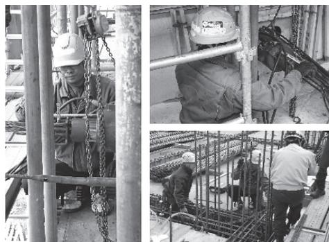
PC鋼7本を緊張させ、鉄筋コンクリートに圧縮力を加えることにより、大きな荷重に耐えられる構造となり、梁の高さを抑えながら、柱の間隔を確保することが可能となっております。
