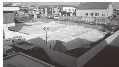
約400m<sup>3</sup>のコンクリートを打設しました。生コンクリート車100台分です。
