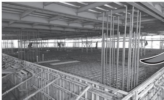
型枠を取り付けて、生コンクリートを流し込む準備をします。
