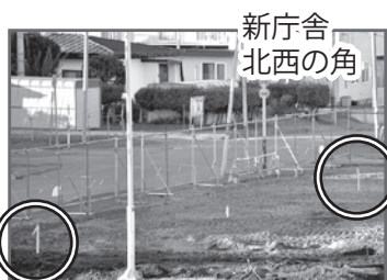
新庁舎 北西の角 新庁舎 南西の角
