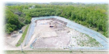
現在の埋立処分場
