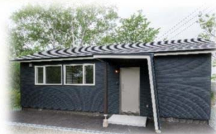
改修後（民泊施設）
