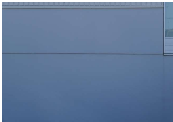
外壁：概ね良好（劣化度A）
