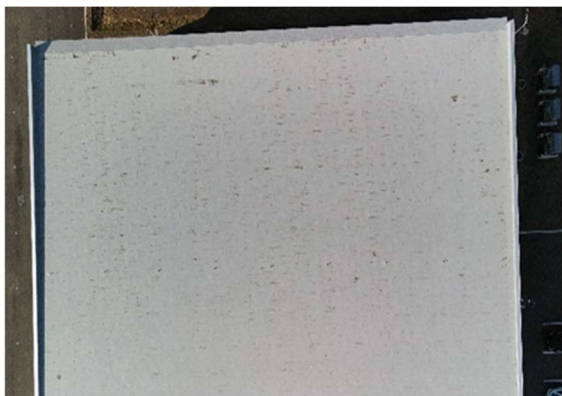
屋根：概ね良好（劣化度A）
