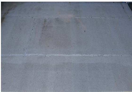
屋根：概ね良好（劣化度A）
