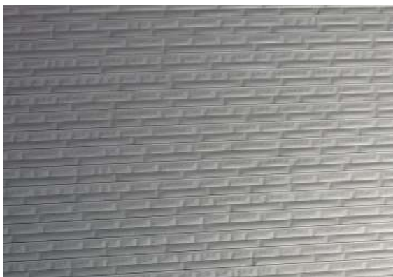
屋根：概ね良好（劣化度A）
