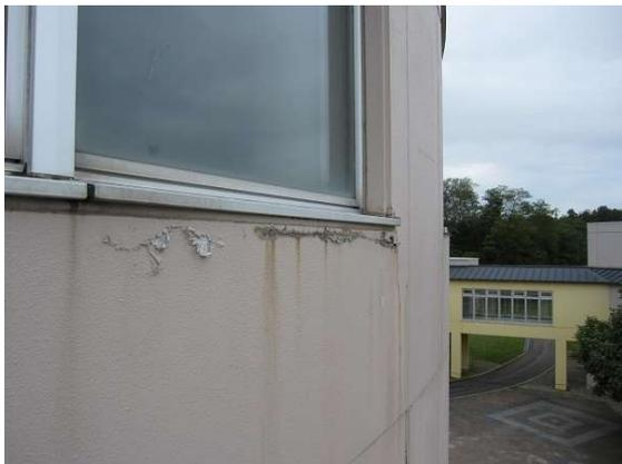
クラック・内部鉄筋の錆汁跡 (劣化度D)
