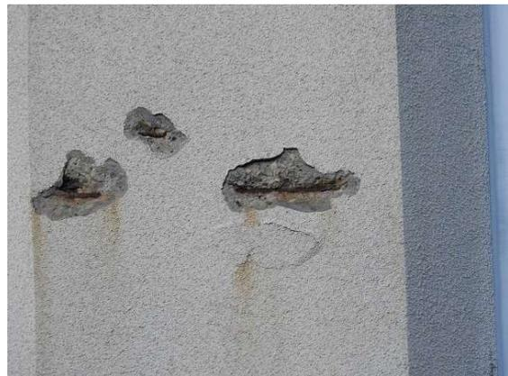
内部鉄筋の露出 (劣化度D)
