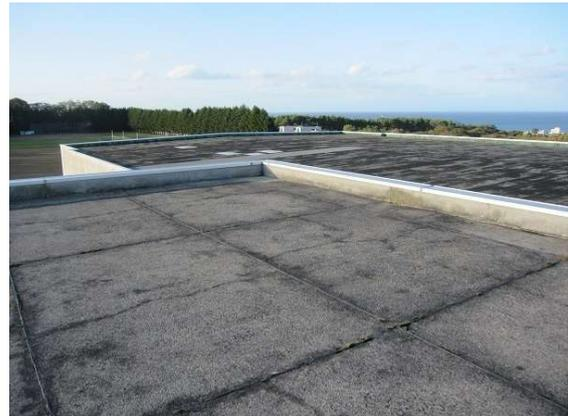
アスファルト防水の劣化 (劣化度D)
